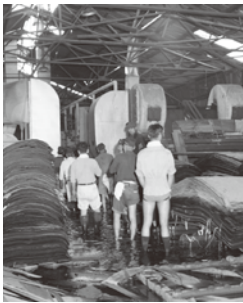
ベニヤ工場の浸水(港区新船町) 昭和34年10月9日
