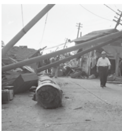
大手橋付近の惨状(港区大手町) 昭和 34 年 9 月 28 日
