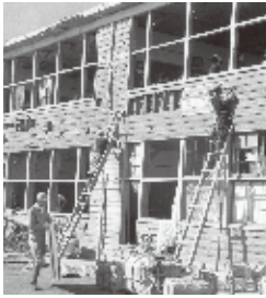
破壊された校舎の修復作業 (南区南光中学校) 昭和34年11月4日
