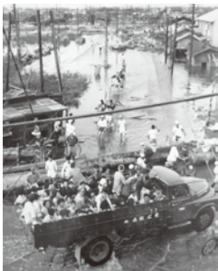
借り上げトラックで避難する り災者(南区名鉄大江駅南付近) 昭和34年9月29日
