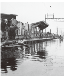
一面に浸水した駅 (南区名鉄常滑線 道徳駅) 昭和34年10月4日
