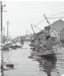
たのみの交通手段となった流木いかだ、小舟 (南区道徳通)昭和34年10月3日
