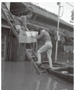
浸水した家屋より家財を運び 出す住民(港区魁町付近) 昭和34年10月5日
