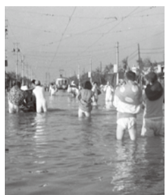
西稲永付近の浸水(港区西稲永) 昭和34年9月28日
