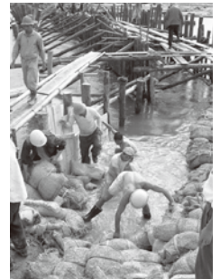
八号地貯木場堤防の応急復旧作業 (南区元柴田西町) 昭和34年10月5日
