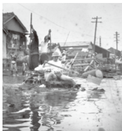
筏にて倒壊家屋の除去作業をする地域奉仕団(南区道徳通) 昭和34年10月3日
