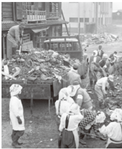
被災後の清掃作業の様子 (港区)日付不明
