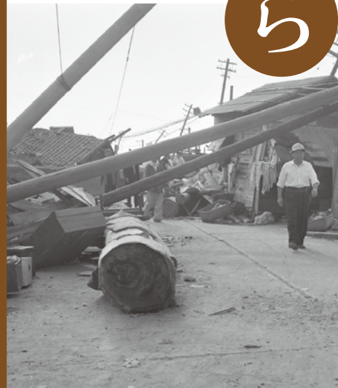
大手橋付近の惨状(港区大手町) 昭和34年9月28日
